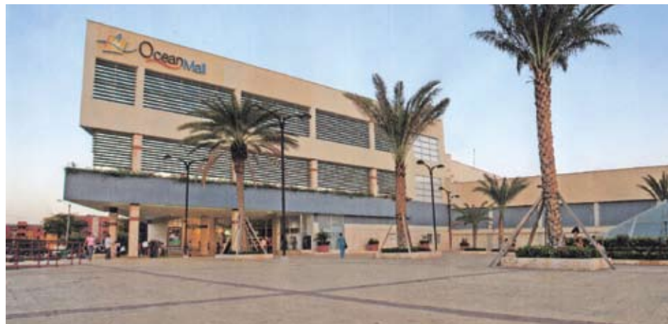
Ocean Mall, Santa Martha, moderno complejo comercial construido en 2005.
